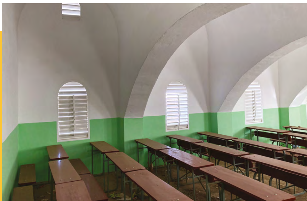
Espace ouvert entre les voûtes grâce à des arcs en bloc de béton plein pour une salle de classe d'une longueur de 9m50 et d'une largeur de 6m50.
